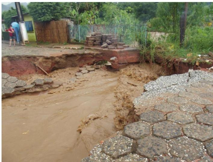
Figura 4. Ponte derrubada pela enchente na cidade de Piranguçu - MG em 2013.
